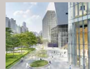
TaiKoo Hui, Guangzhou 廣州太古滙
